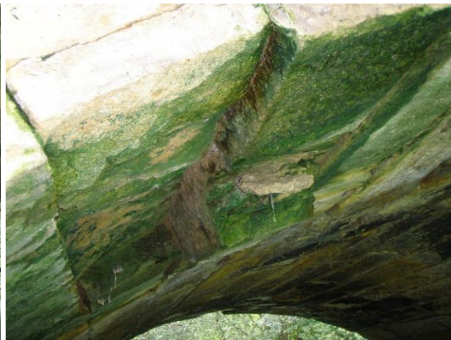
detail prasklého a odpadlého kvádru
