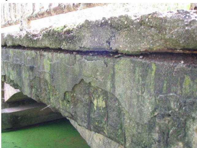
detail rozpadlé římsy a boku NK vpravo na konci mostu
