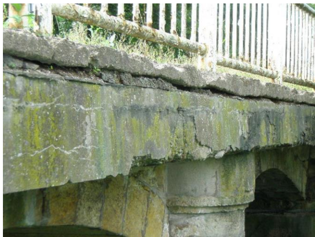
rozpadlý beton na boku římsy vpravo
