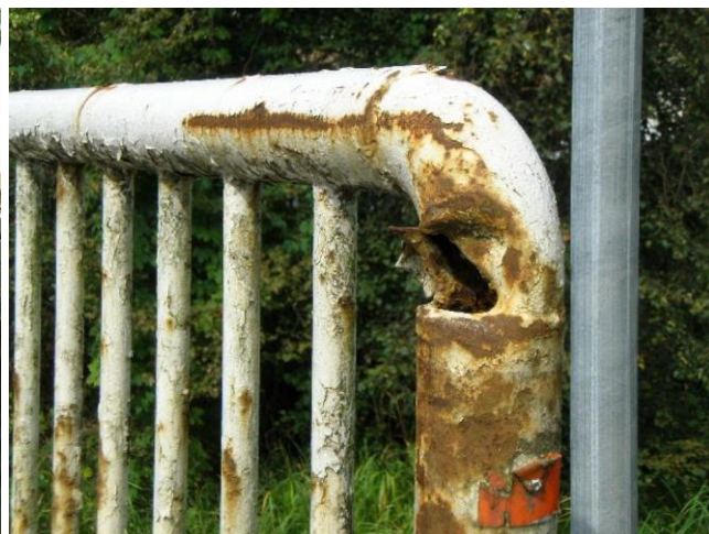
silná koroze zábradlí
