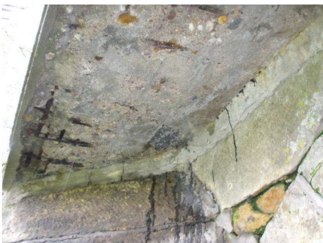
hloubkově degradovaný beton na podhledu rozšířené NK vpravo
