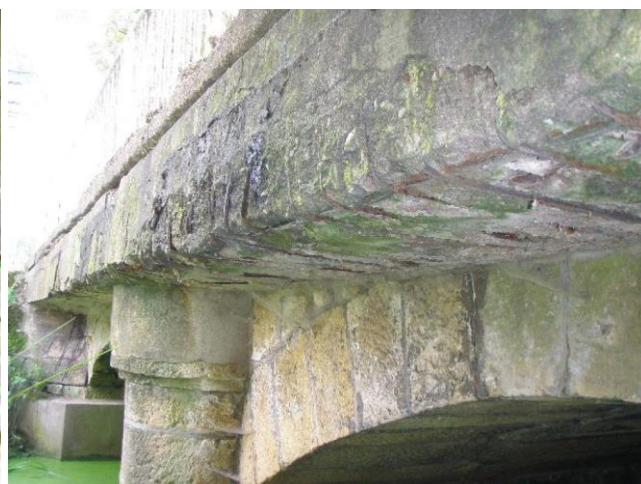
obnažená a zkorodovaná výztuž na boku a podhledu rozšíření NK vpravo
